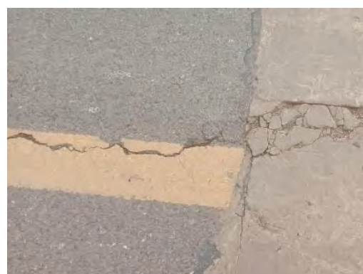
路面裂缝
