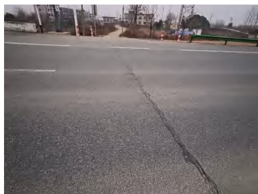
桥面裂缝
