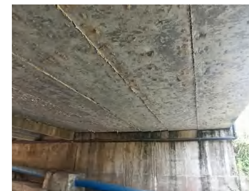
主梁空心板底混凝土剥离、露筋锈蚀、铰缝脱落
