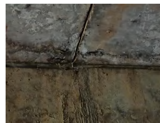
主梁板底混凝土裂缝、剥离、露筋锈蚀
