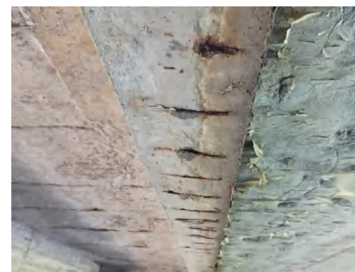
主梁空心板底混凝土剥离、露筋锈蚀、铰缝脱落
