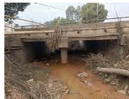
桥梁现状立面
