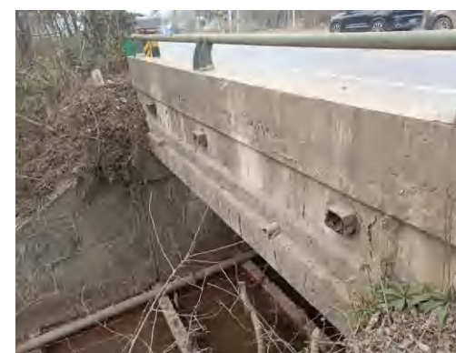
桥梁现状立面
