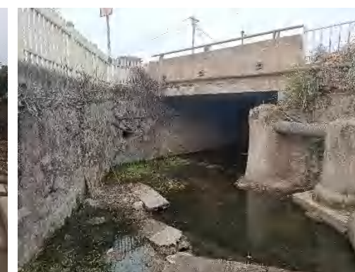
桥梁现状立面
