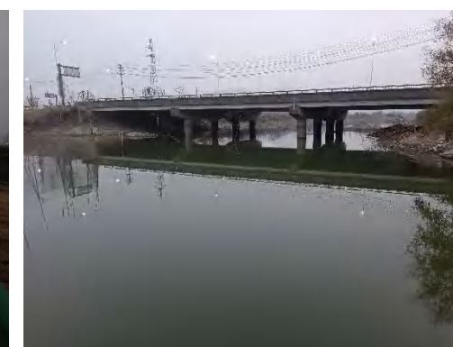
桥梁现状立面
