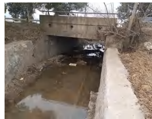
桥梁现状立面
