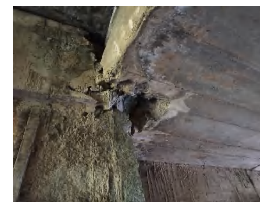
主梁板底混凝土裂缝、剥离、露筋锈蚀
