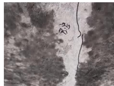
空心板底板纵向裂缝
