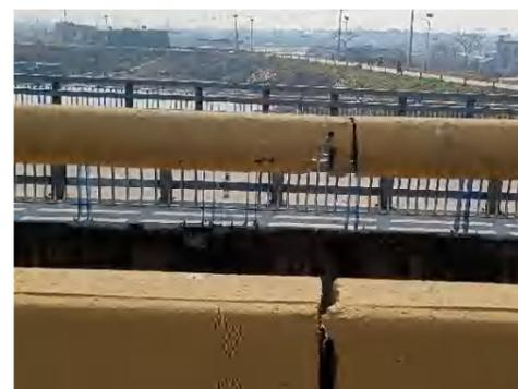
护栏钢扶手锈蚀破损
