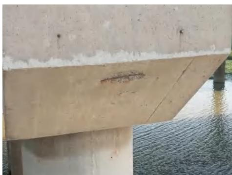
桥墩盖梁混凝土剥蚀露筋
