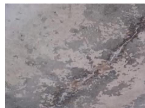
空心板底板纵向裂缝
