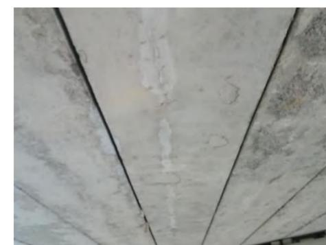
空心板底板纵向裂缝
