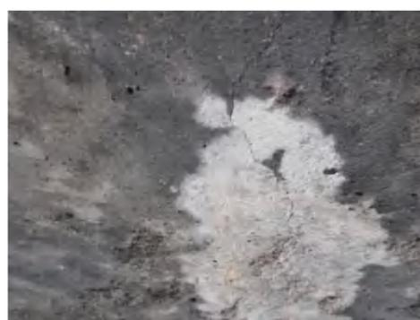
空心板底板纵向裂缝
