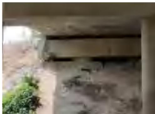
桥台台帽局部混凝土水蚀
