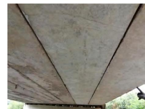
空心板底板纵向裂缝
