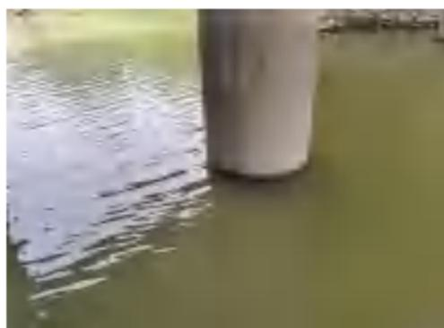
桥墩底部、中部水流冲刷，粗集料大量外露
