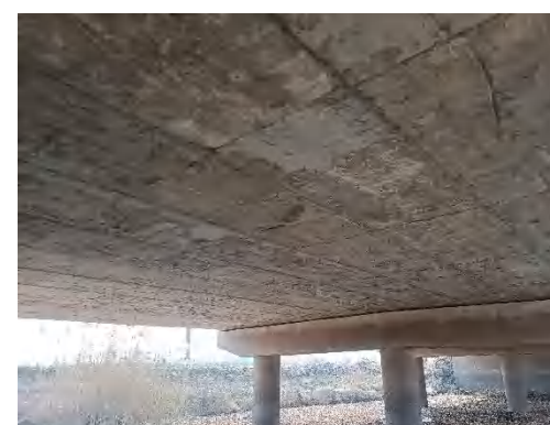
主梁空心板底横向裂缝
