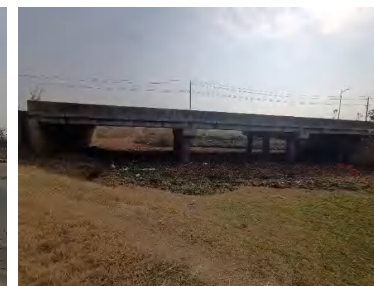
桥梁现状立面
