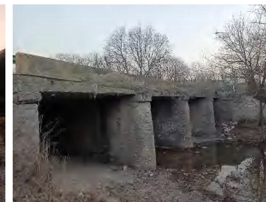
桥梁现状立面
