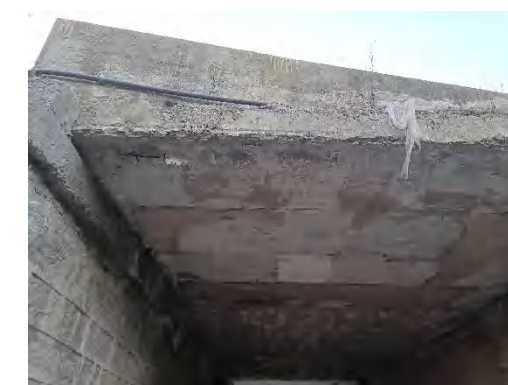
主梁空心板底混凝土剥离、露筋锈蚀、裂缝
