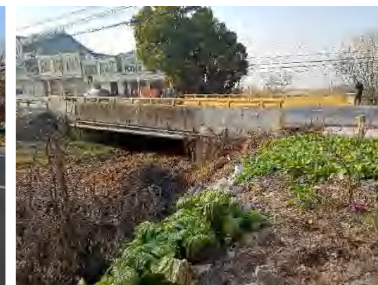
桥梁现状立面
