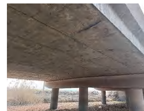
主梁空心板底横向裂缝
