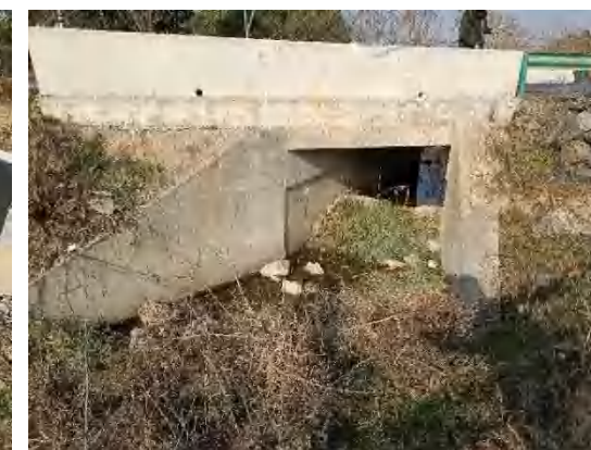
桥梁现状立面
