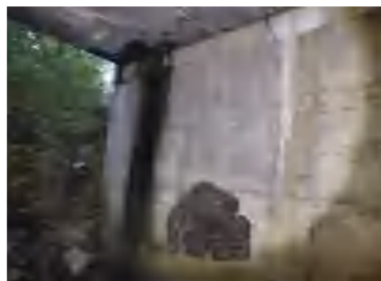
局部混凝土水蚀麻面
