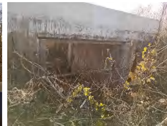
桥梁现状立面
